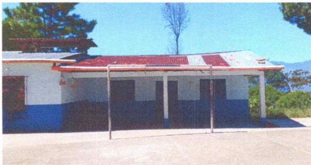
Foto 9: Sustitución de lamina, modulo 4.
