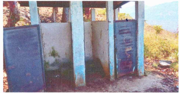
Foto 8: Sustitución de puertas en mal estado por nuevas.
