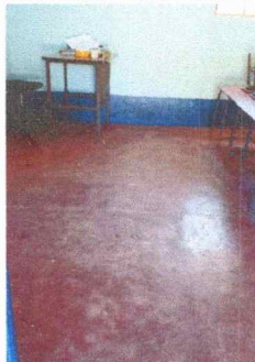
Foto 11: Instalación de piso ceramico en modulo 2.
